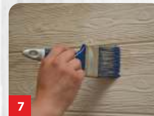
7 Gruntowanie pod lakier.
