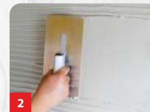
2 Nakładanie tynku.
