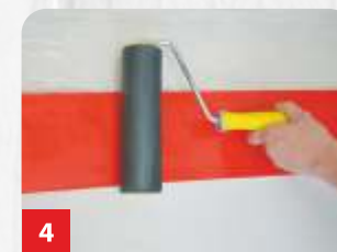
4 Odciskanie matrycy w tynku.
