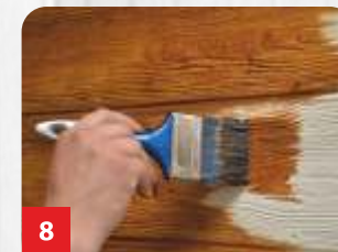
8 Nakładanie impregnatu koloryzującego.
